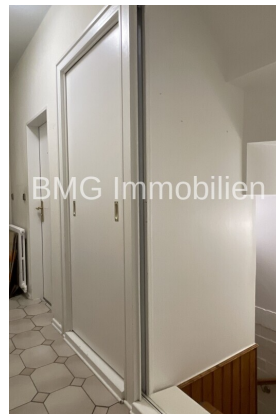
Zugang zum Dach und zum Keller
