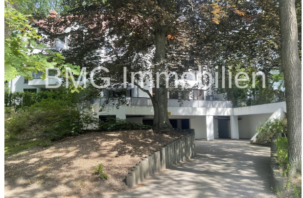
Auffahrt zu den Parkplätzen
