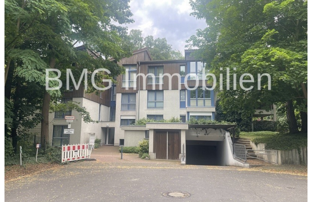
Grundstück mit Einfahrt zur Tiefgarage
