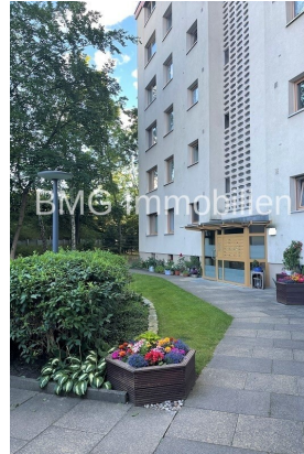
Zugang zum Hauseingang
