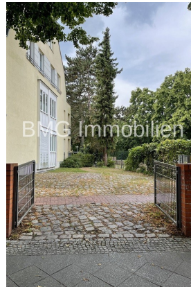
Auffahrt zum PKW-Stellplatz
